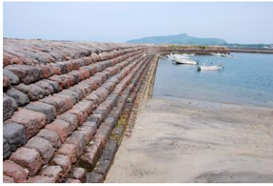
宮ヶ浜港防波堤（捍海隄）
