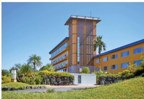
錦江楼の外観
